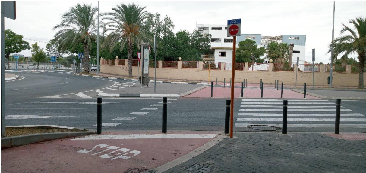
Gráfica 128. Carril bici en acera Avenida del Hospital
