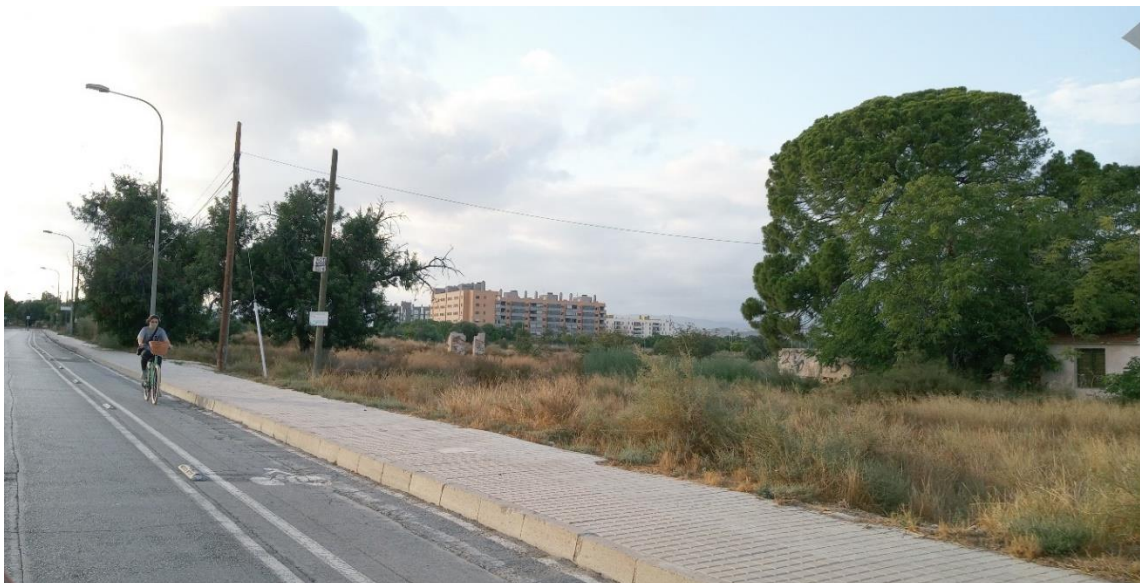
Gráfica 130. Carril bici en calzada de la calle del Secretario Basilio Sala
