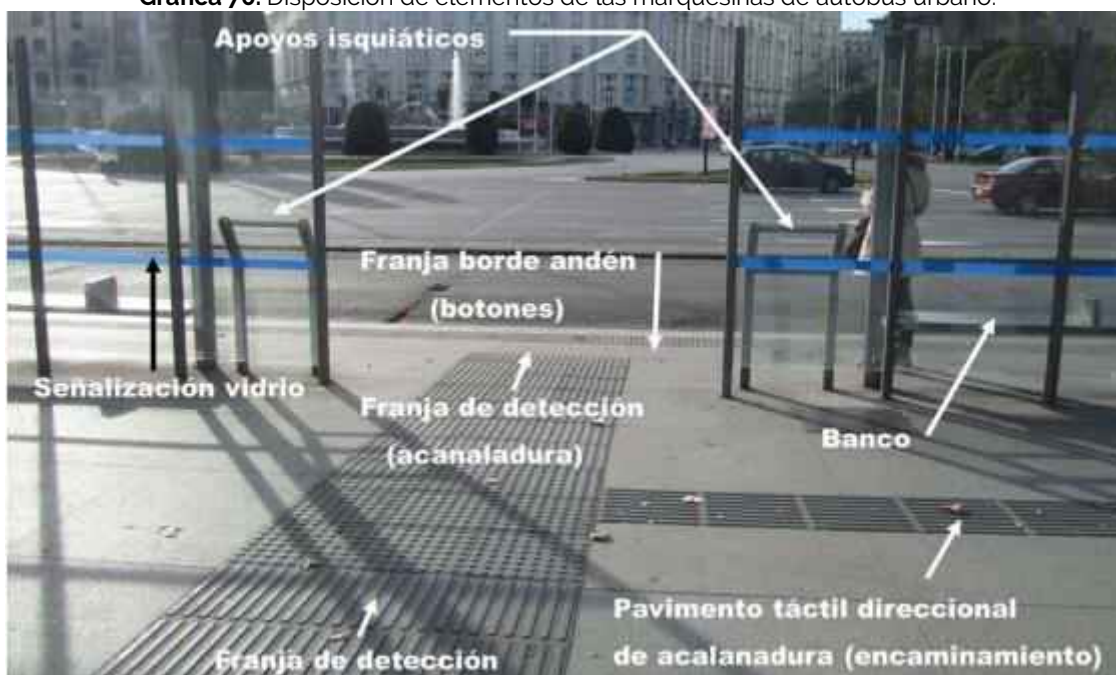
Gràfica 70. Disposición de elementos de las marquesinas de autobús urbano.
