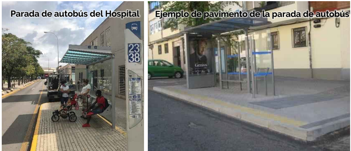
Gráfica 68. Ejemplo de parada de Sant Joan d'Alacant (izquierda) y de parada de autobús de Madrid (derecha).
